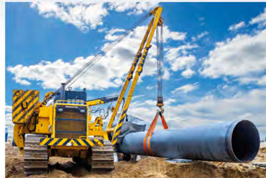
Укладка трубопровода
