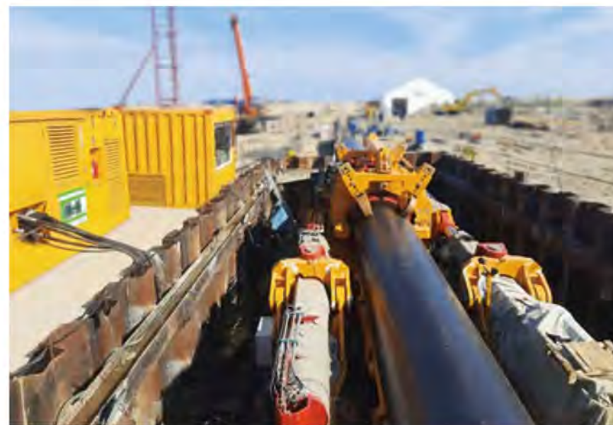
Метод Direct Pipe — уникальная технология, применяемая на Уренгойском месторождении
