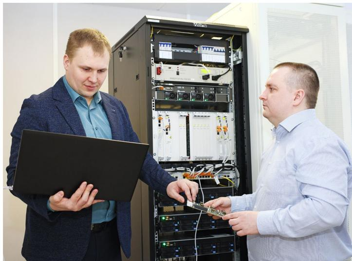
Инженеры электросвязи Арсений Резников и Ярослав Цибуляк проводят комплекс необходимых работ на установленной в рамках программы импортозамещения автоматической телефонной станции «ПРОТЕЙ-imSwitch СП»
