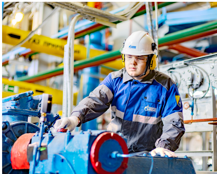
Электромонтер по ремонту и обслуживанию электрооборудования газового промысла № 7 Динис Каримов
