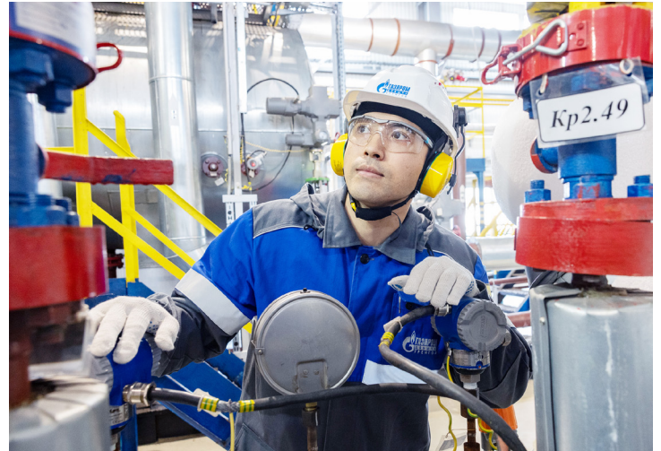
Осмотр технологического оборудования промысла осуществляет инженер по ремонту ГКП-22 Талгат Бекбасов
