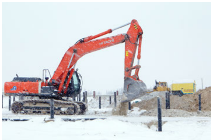
На данном этапе основные работы — это отсыпка грунта, забивка свай и их испытания
