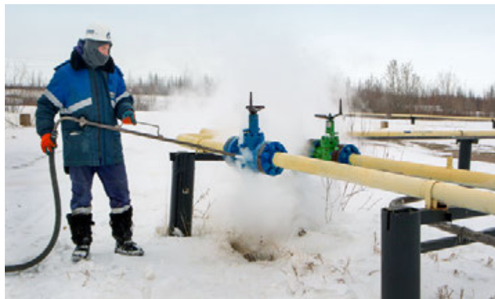
Оператор по добыче нефти и газа Уренгойского газопромыслового управления Рашит Алмаев устранил наледь с задвижки
