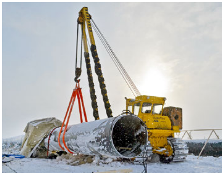
Работы по замене резервной нитки газового коллектора УКПГ-8 — УКПГ-13 у реки Арка-Таб-Яха
