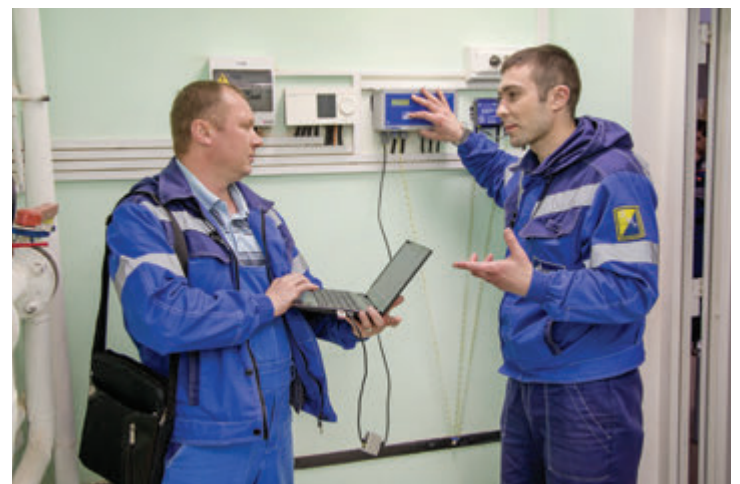
Слесари по КИПиА Сергей Аристов и Дмитрий Гейдельбах снимают показания с узла учета тепловой энергии
