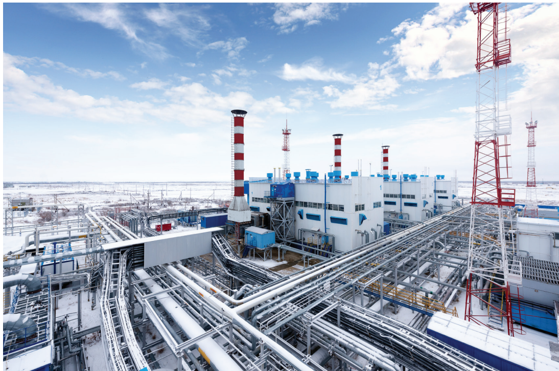
2017 год. Компрессорная станция цеха по добыче газа, газового конденсата, нефти № 1
