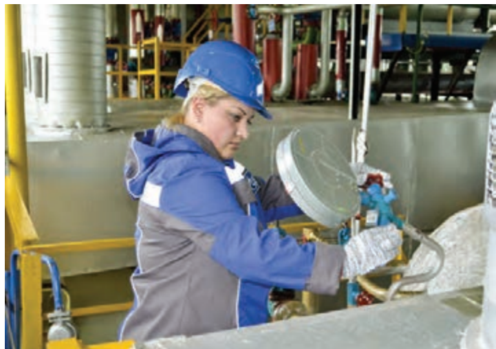
Оператор котельной ГКП-11 Ольга Ситникова продувает манометр давления пара
