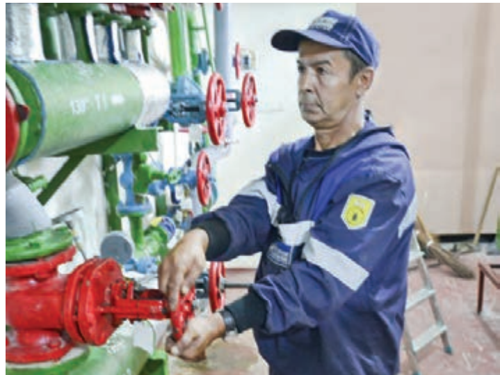
Сантехник Виктор Маркин проводит ревизию запорной арматуры в тепловом узле административного здания ИТЦ
