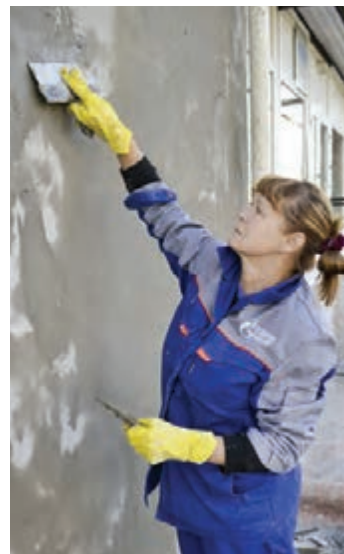
Маляр Ольга Горбиль штукатурит стену здания научной библиотеки ИТЦ
