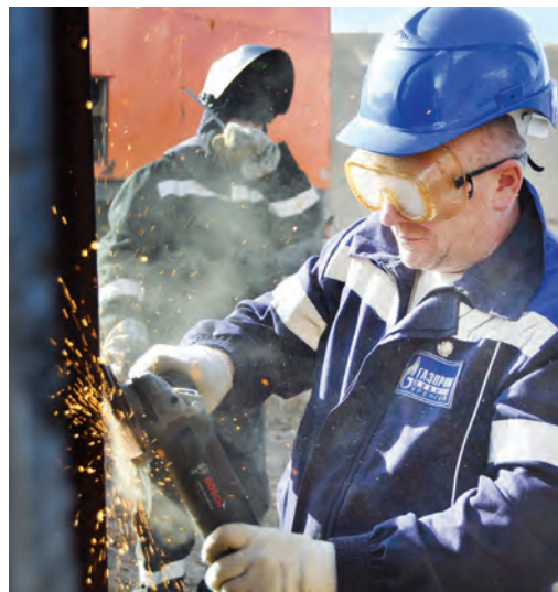
Сергей Колебанов, монтажник технологических трубопроводов, подготавливает кромку стыка
