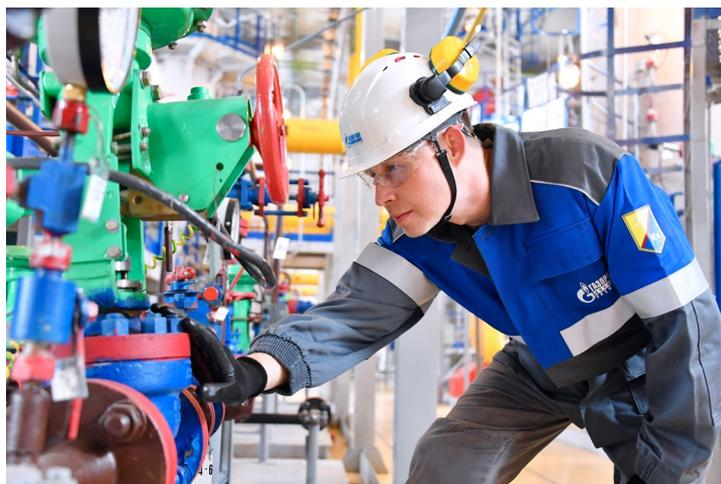
Слесарь по ремонту технологических установок Руслан Набиуллин осматривает состояние уплотнения клапана регулятора газа
