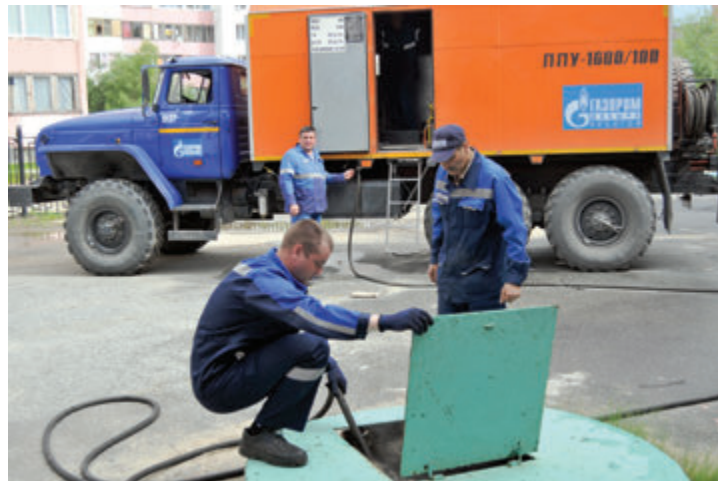
Работники УАВР — слесари-ремонтники Антон Журавков, Александр Гриценко и слесарь по обслуживанию тепловых сетей Игорь Деркач — проводят пропарку канализации от жиров возле детского сада «Росинка»
