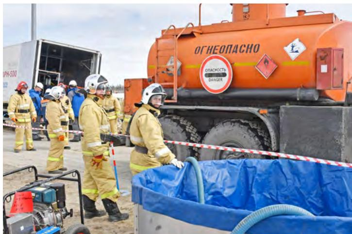
Так осуществляется перекачивание нефтепродуктов из зоны разлива через промежуточную емкость в автоцистерну
