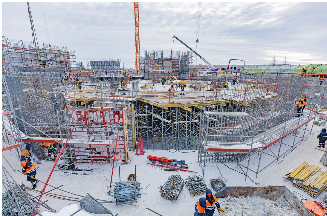
На площадке будущего офисного здания газодобывающего предприятия
