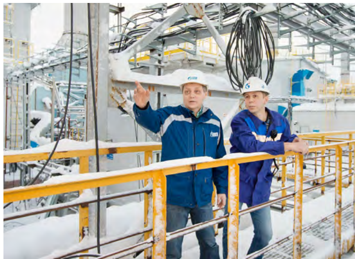
Заместитель начальника УГПУ по дожимным компрессорным станциям и станциям охлаждения газа Игорь Белявин и заместитель начальника ГКП-8 по ДКС Алексей Ткаченко на стройке компрессорной станции на УКПГ-8В
