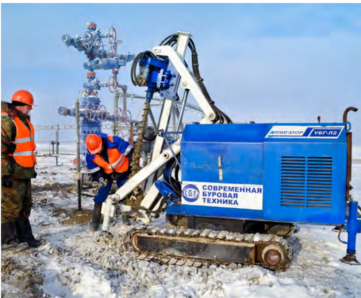
Термостабилизация грунта на строящемся 39-м кусте ГКП-22
