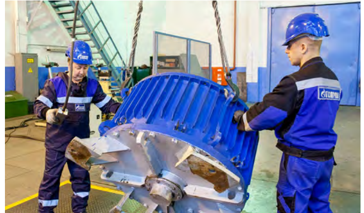
Бригадир Флор Зубаиров и слесарь Николай Бажов за сборкой электродвигателя АВО газа
