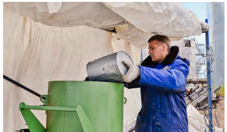
По словам подрядчиков, самая трудоемкая часть ремонта резервуаров — пескоструйная очистка
