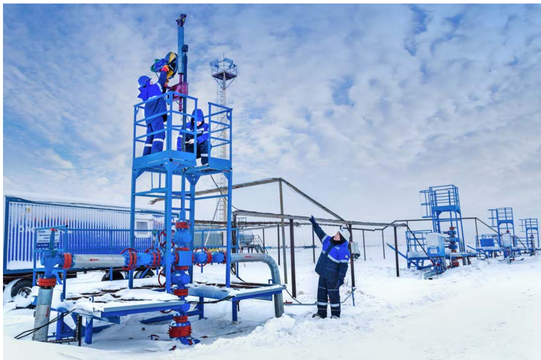
2017 год. Куст скважин второго нефтепромысла. Ведутся работы по обслуживанию устройства очистки колонны насосно-компрессорных труб >>> стр. 2
