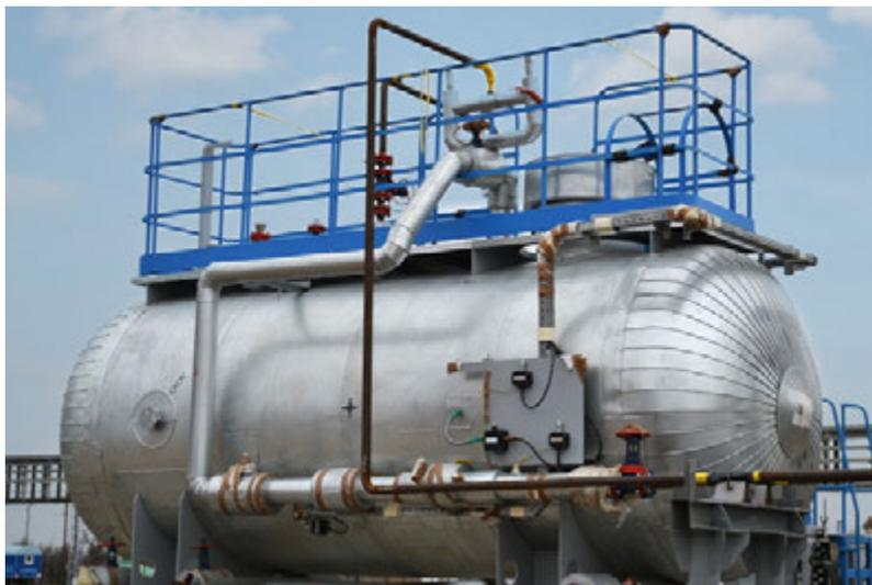
*Обвязка исследовательского сепаратора на строительной площадке куста скважин*
