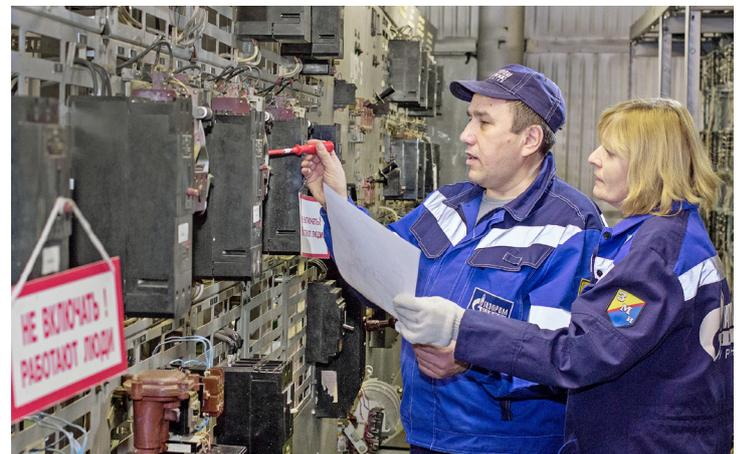
Во время подготовительных мероприятий энергетики УГПУ стремятся уделить внимание всем объектам. Электромонтеры по ремонту и обслуживанию электрооборудования газового промысла № 1 Валерий Павлов и Снежанна Хусаенова проводят техобслуживание пусковой аппаратуры в распределительном устройстве
