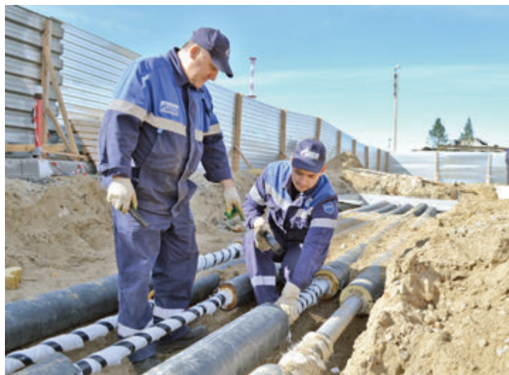
Слесарь по ремонту оборудования тепловых сетей УАВР Олег Паршаков и слесарь-ремонтник того же Управления Алексей Кудинов проводят осмотр трубопроводов перед проведением работ по изоляции
