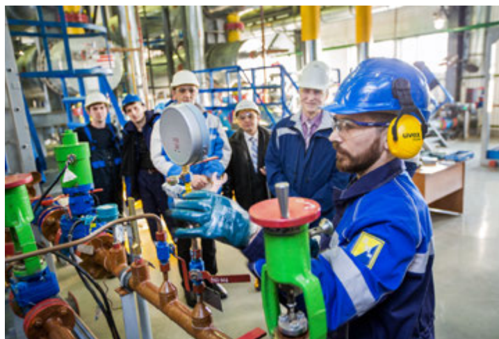
Установку манометра выполняет оператор по добыче нефти и газа Уренгойского газопромыслового управления Ильдар Фатхутдинов
