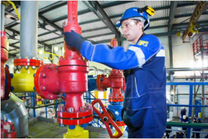
Александр Резанов проверяет срок тарировки сбросного пружинного предохранительного клапана
