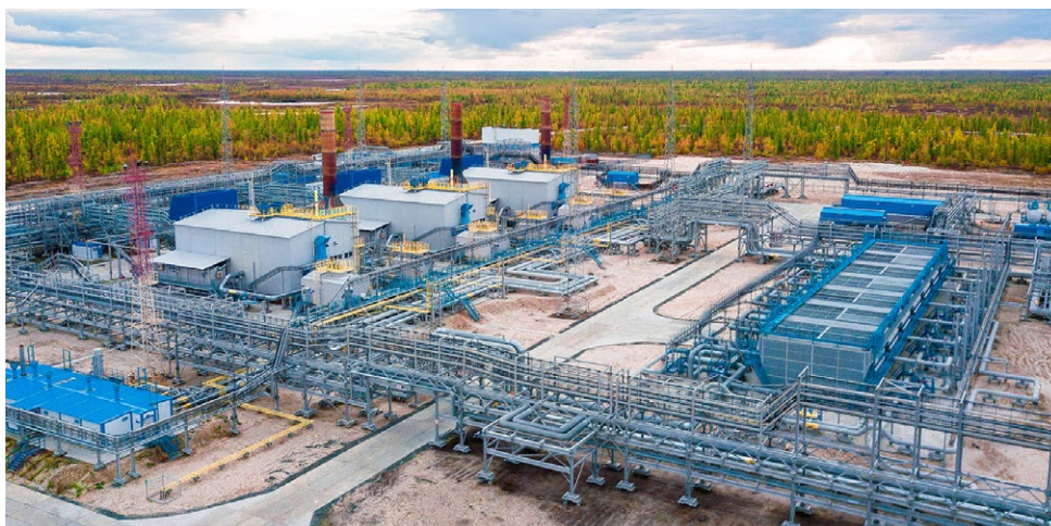
Производственные объекты Уренгойского нефтегазоконденсатного месторождения
