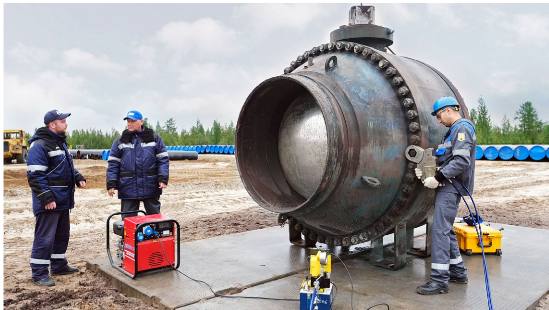
Сотрудники Управления аварийно-восстановительных работ разбирают корпус шарового крана
