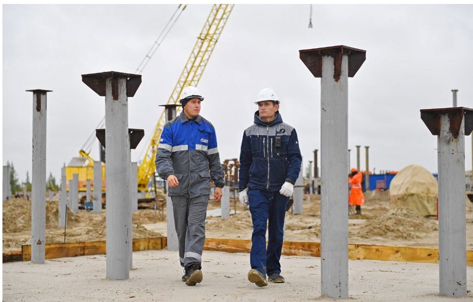
На строительной площадке УКПГ-21 с подрядчиками общается Руслан Гиззатуллин (слева), мастер по добыче нефти, газа и конденсата ГПУнРАО
