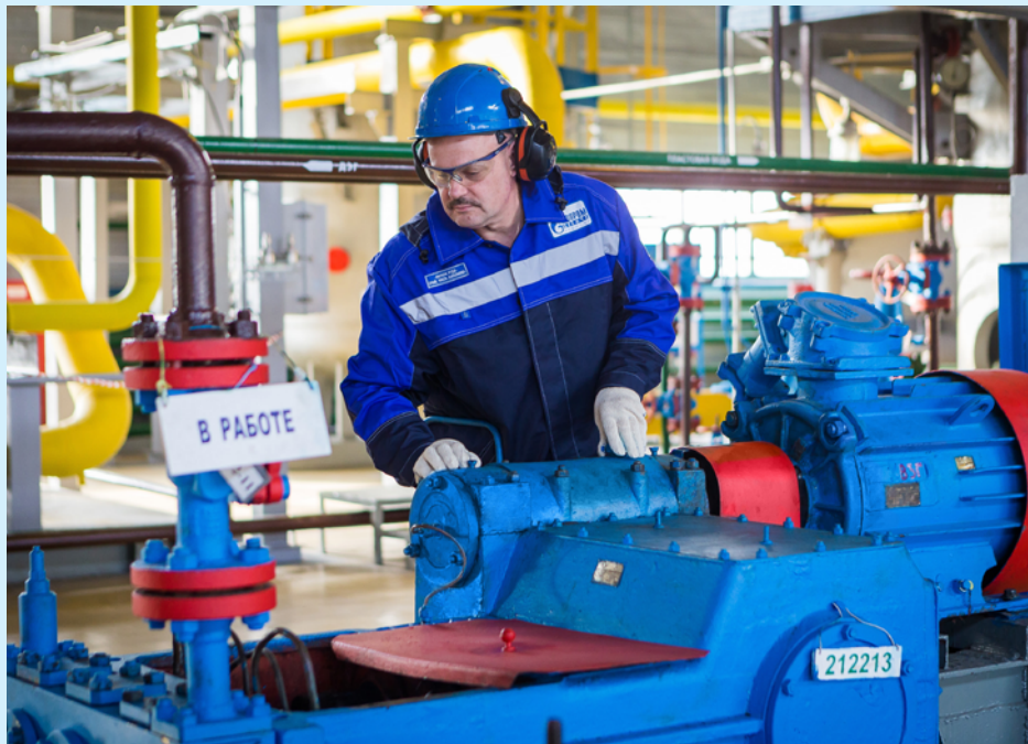
Слесарь-ремонтник газового промысла № 1 Александр Иванов контролирует работу насоса, перекачивающего диэтиленгликоль
