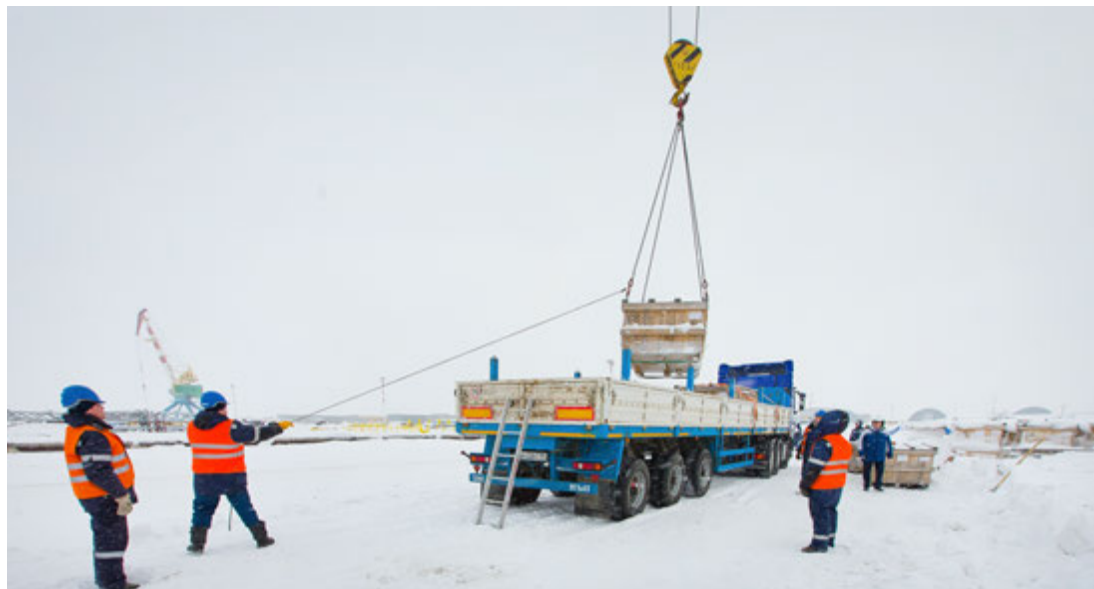
Погрузочно-разгрузочные работы на площадке УМТСиК
