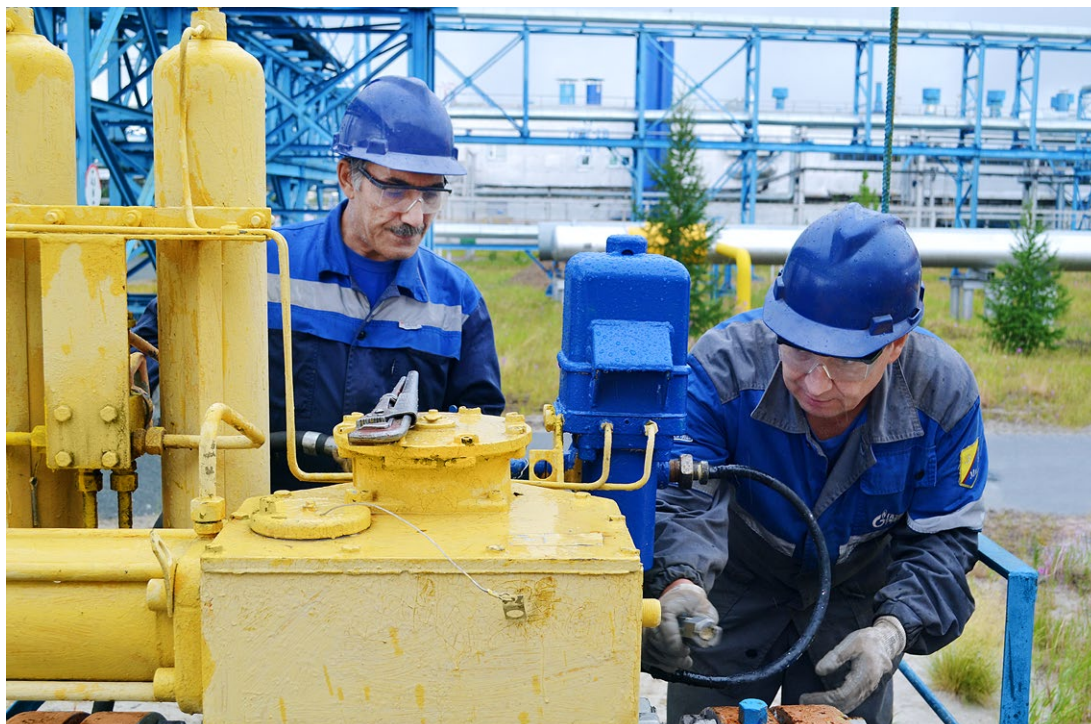
Слесари-ремонтники Дамир Тапдыгов и Шагабутдин Сулейманов набивают герметизирующую смазку в шаровой кран
