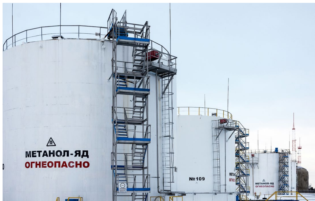
Резервуарный парк Управления материально-технического снабжения и комплектации
