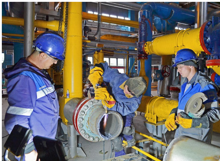
Электрогазосварщики Руслан и Султан Исенгуловы, Андрей Бычков проводят огневые работы на шаровом кране во втором технологическом цеху промысла
