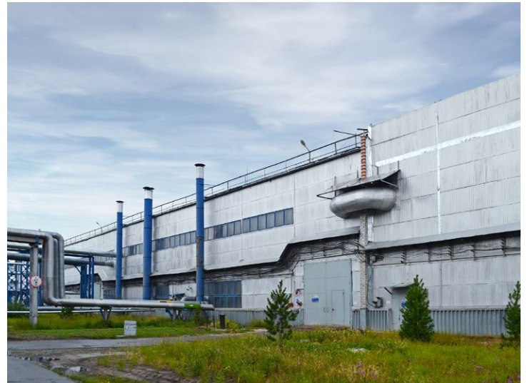
Технологический цех газоконденсатного промысла № 2
