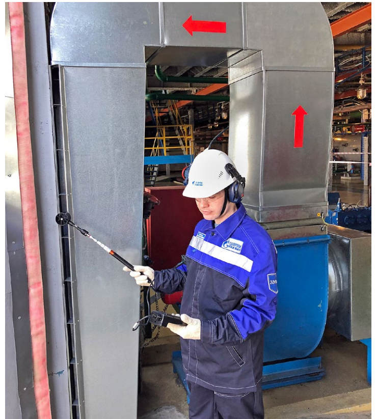
Инженер лаборатории контроля и исследования систем вентиляции Алексей Днепровский
