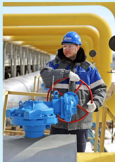
Машинист технологических компрессоров ГКП-1А Евгений Куроедов открывает входной шаровой кран для запуска секции аппарата воздушного охлаждения газа в работу
