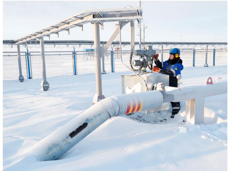
*Узел приема очистного устройства газопровода-шлейфа куста газоконденсатных скважин ГКП-22. Вся запорная арматура оснащена электроприводами, которыми можно управлять прямо с пульты промысла. Именно сюда приходит поршень после очистки газопровода-шлейфа. Оператор по добыче нефти и газа Рустем Гарипов перед извлечением поршня из камеры приема подготавливает оборудование к безопасной работе*
