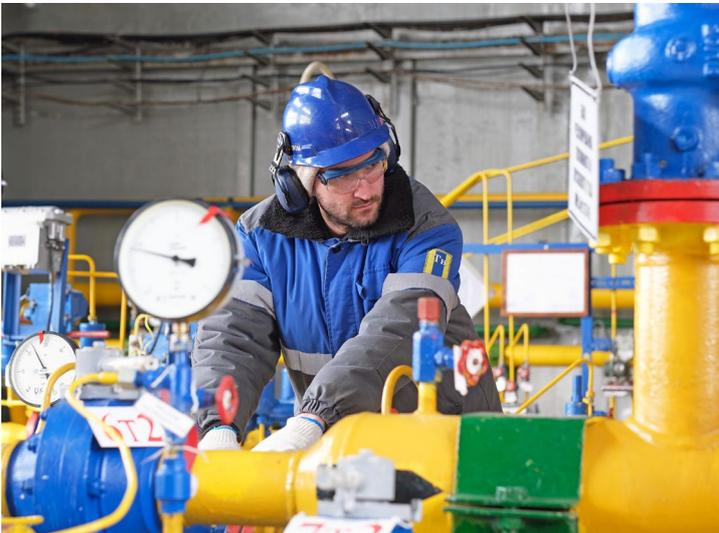
От «а» до «я» разбирается в технологических системах промысла Анатолий Корвин, машинист технологических компрессоров ГП-4. Наш фотокорреспондент застал его в блоке подготовки топливного, пускового и импульсного газа за регулировкой давления топливного газа в газоперекачивающих агрегатах
