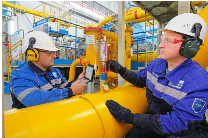
Инженеры отдела технологического мониторинга нефтепромысловых систем Константин Рыцев и Алексей Ганжа производят контроль и мониторинг термобарических параметров с целью выбора оптимального технологического режима работы оборудования подготовки попутного нефтяного газа, а также улучшения качества углеводородной продукции на нефтяных промыслах Уренгойского месторождения
