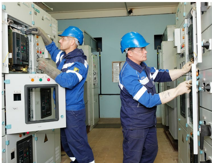
Электромонтеры по ремонту и обслуживанию электрооборудования Максим Либерт и Ирик Абдулов производят ревизию оборудования в трансформаторной подстанции № 5А
