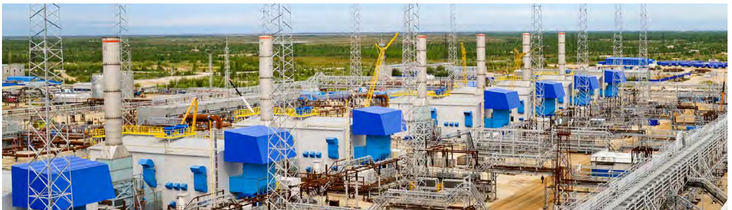
На строительной площадке ДКС-1АВ. Фото Сергея ЗЯБРИНА
