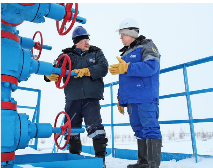
Оператор по добыче нефти и газа Сергей Бабанец под руководством мастера по добыче нефти, газа и конденсата Рустама Миняева проводит техническое обследование состояния фонтанной арматуры
