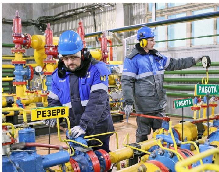
Блок подготовки топливного, пускового и импульсного газа дожимной компрессорной станции. Машинист технологических компрессоров Максим Пышиненко и слесарь по контрольно-измерительным приборам и автоматике Александр Ефимов настраивают регулятор давления пускового газа
