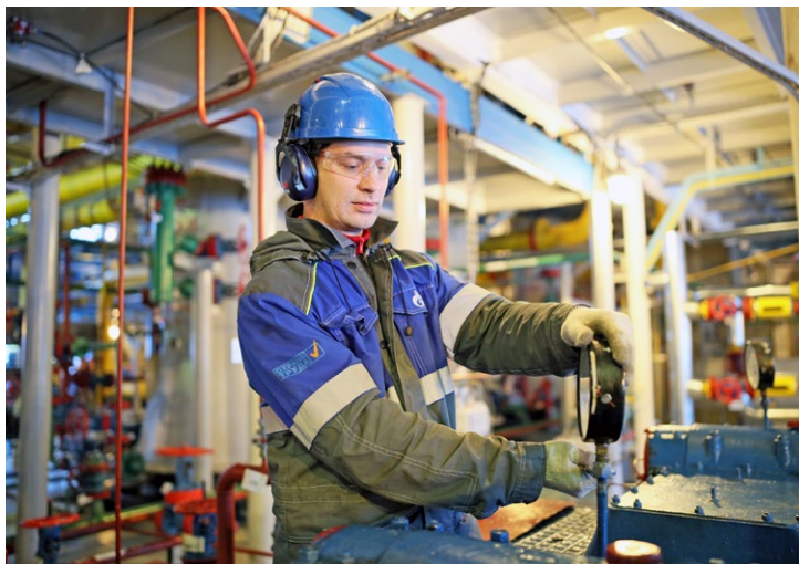
Слесарь по контрольно-измерительным приборам и автоматике Евгений Воробьев выполняет замену вышедшего из строя манометра на насосе подачи диэтиленгликоля в абсорберы
