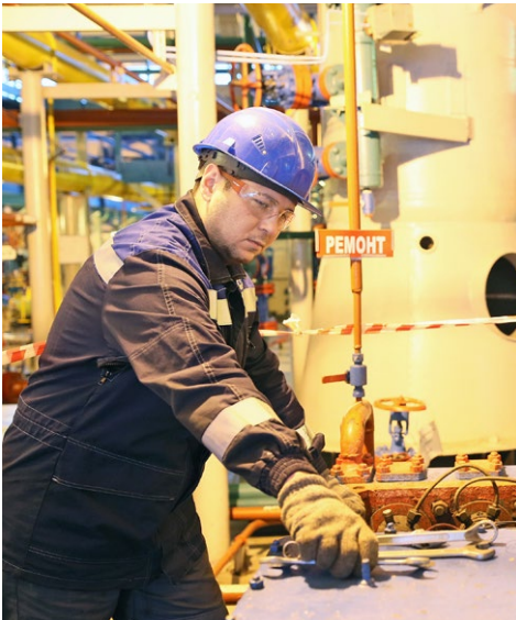
В соответствии с графиком планово-предупредительных работ слесарь-ремонтник Ярослав Петрович в первом цехе ремонтирует насос подачи диэтиленгликоля в абсорберы
