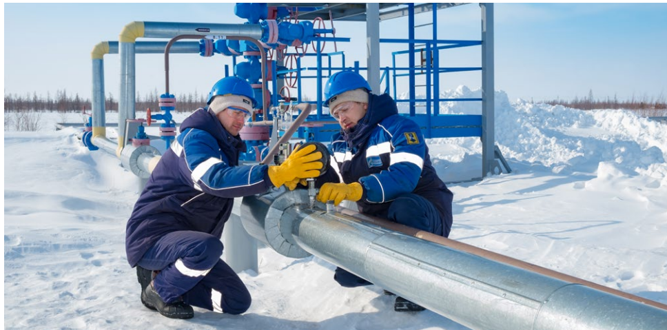
Операторы по добыче нефти и газа ГКП-2 Азат Баязитов и Артур Галездинов запускают скважину в работу после ее остановки на ремонтные мероприятия
