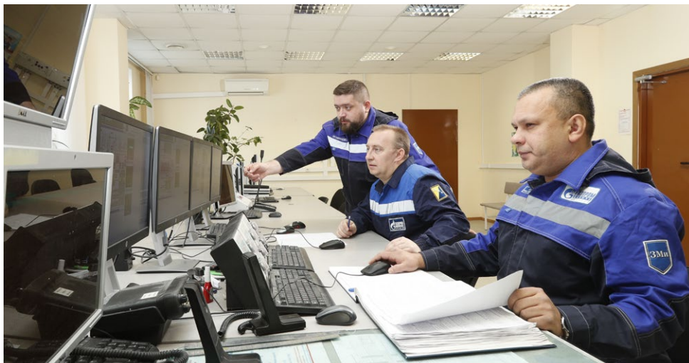
Машинист технологических компрессоров Максим Ивченко и сменные мастера по подготовке газа Сергей Коник и Рустэм Даутов на пульте в операторной компрессорной станции НП-2 контролируют параметры работы газоперекачивающих агрегатов
