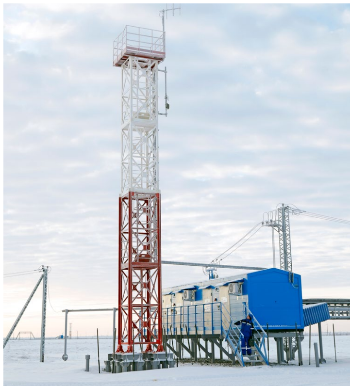
Для организации канала связи на кусте газоконденсатных скважин ГКП-22 на верхней секции мачты установлена система беспроводного широкополосного доступа WIMIC-6000
