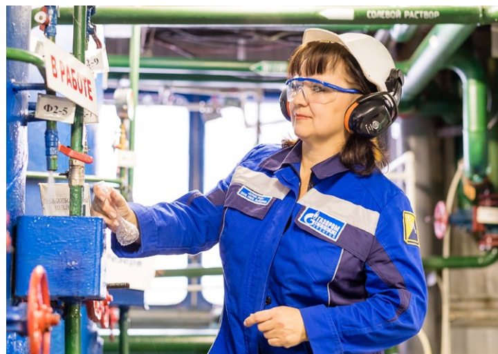
Аппаратчик химводоочистки Наталья Аброськина отбирает пробы после фильтрации
