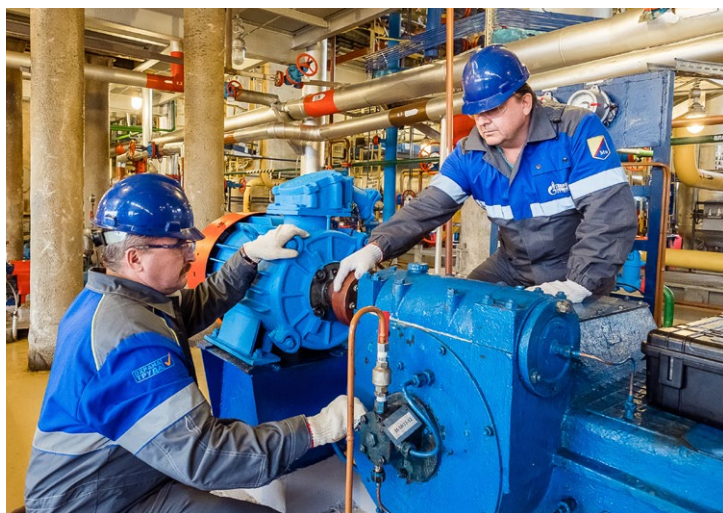
Центровку насоса в технологическом цехе № 2 проводят слесари-ремонтники Магзур Закиров и Игорь Захаров
