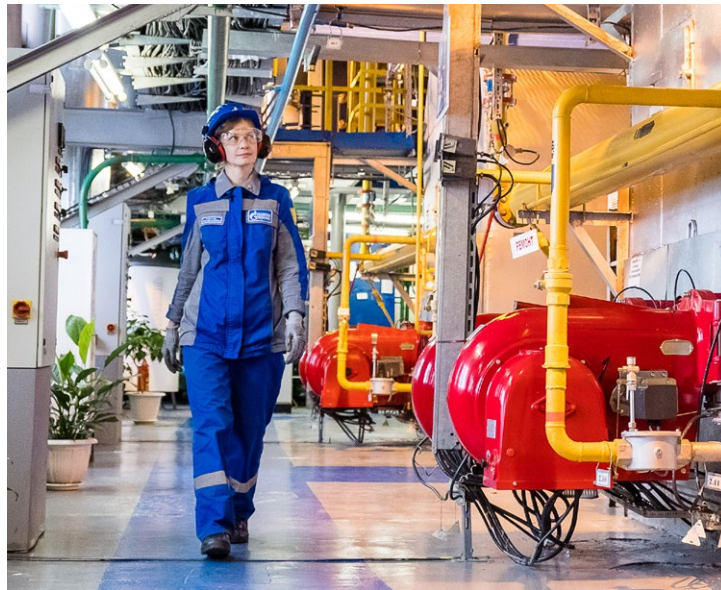
Оператор котельной Марина Кульчева во время обхода
