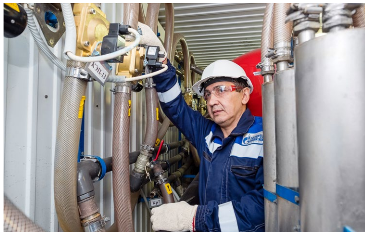
Слесарь-сантехник Эльвир Мансуров проверяет работу клапанов системы очистки воды
