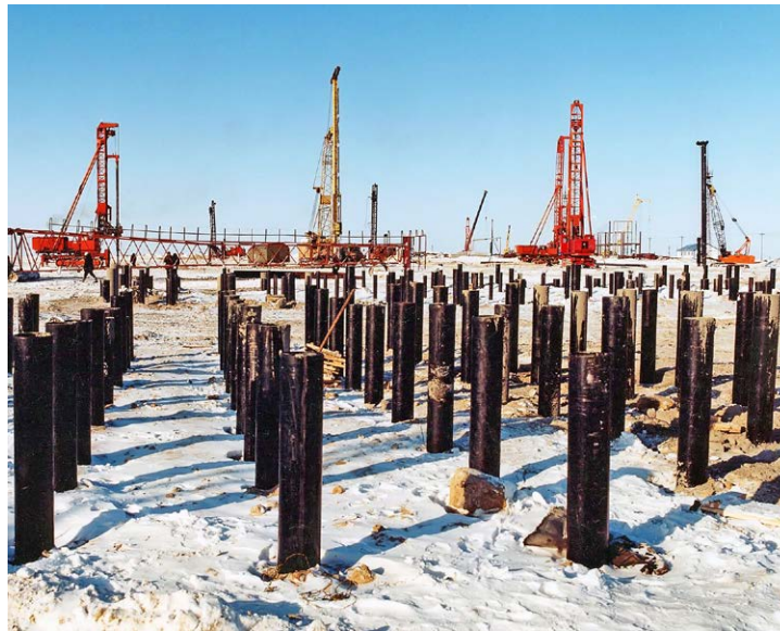
Строительная площадка ГП-16. Начало
