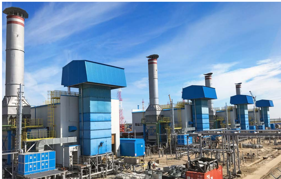
На строительной площадке ДКС-16
