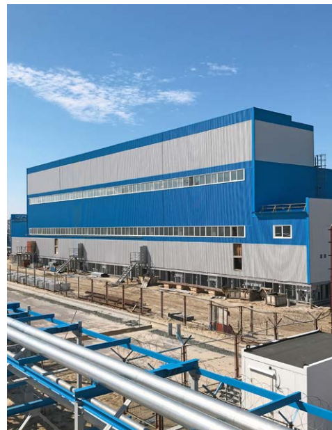
Цех очистки газа
