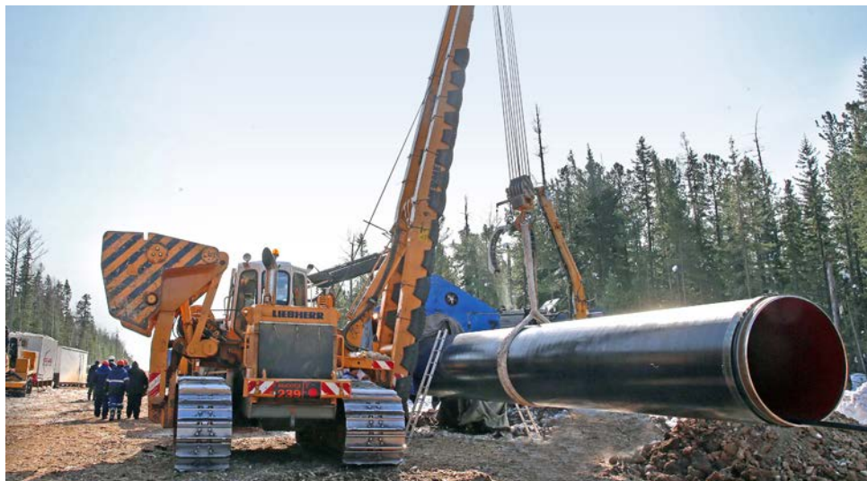
Строительство газопровода «Сила Сибири»
