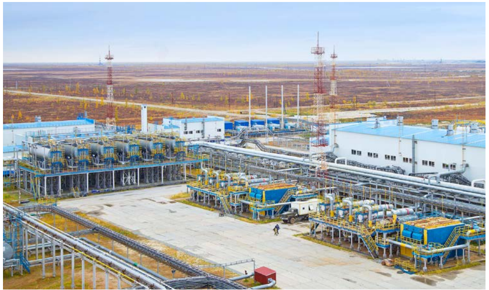
Газоконденсатный промысел № 22 Газопромыслового управления по разработке ачимовских отложений Общества «Газпром добыча Уренгой»
