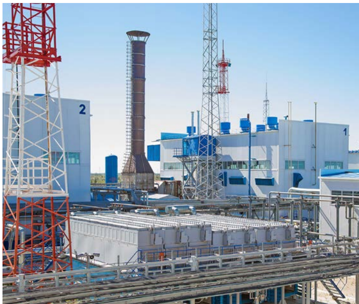
На НП-1 Нефтегазодобывающего управления ведутся работы по техническому освидетельствованию оборудования, набивке запорной арматуры, ревизии крепежных элементов. Плановый останов промысла продлится до 10 июня. Нефтяникам помогают специалисты Управления аварийно-восстановительных работ и Управления технологического транспорта и специальной техники
