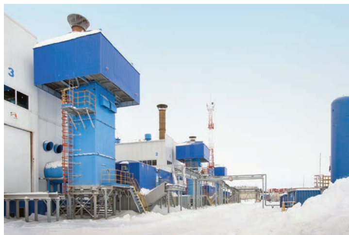
На производственных объектах НП-2
