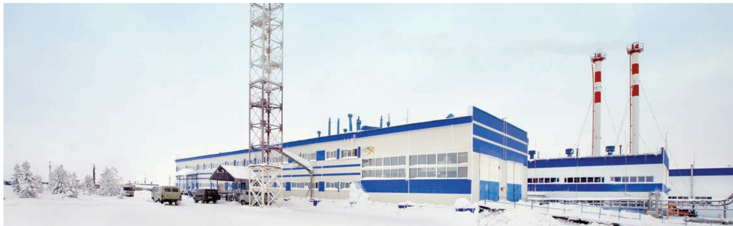
Административно-бытовой корпус нефтепромысла № 2 НГДУ
