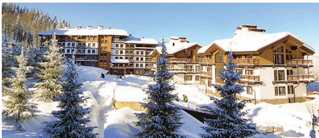
Один из объектов, построенных ОАО «Газпром», — горная олимпийская деревня для лыжников и биатлонистов на 1100 мест. Впоследствии она станет гостиничным комплексом для гостей горно-туристического центра ОАО «Газпром»
