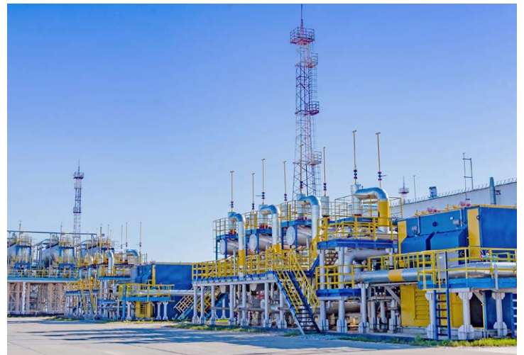
Свежеокрашенное оборудование площадки теплообменников и аппаратов воздушного охлаждения газа ГКП-22 летом 2017 года. Фото Михаила Савинова
