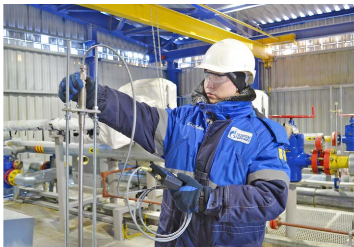
Инженер группы защиты от коррозии и защитных покрытий службы технической диагностики Инженерно-технического центра Юрий Соловьев проводит измерения скорости коррозии для оценки эффективности ингибиторной защиты на объектах ГПП-22. Фото Сергея Зябрина
