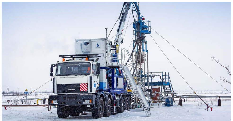
Работы по капитальному ремонту на одной из скважин ГКП-1АВ
