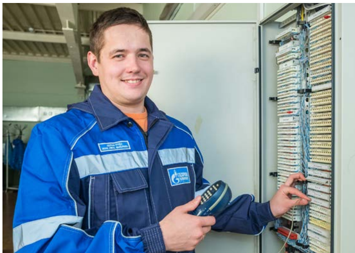
Электромонтер линейных сооружений телефонной связи и радиотелефонии Управления связи Александр Данилишин ведет плановые работы на абонентском кроссе
