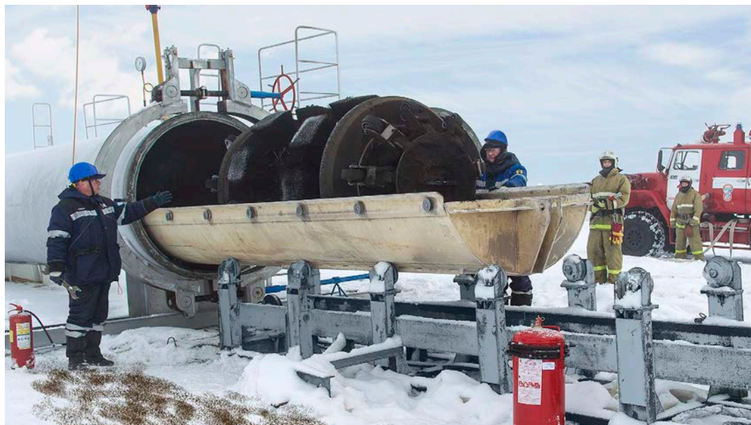
На площадке у камеры приема очистного устройства
