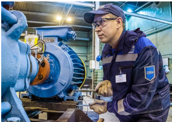
Игорь Корнейчик, слесарь-ремонтник УГПУ, производит затяжку крепления электродвигателя насосного агрегата
