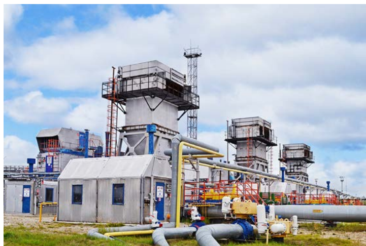
Масштабные летние работы были проведены также на дожимной компрессорной станции
