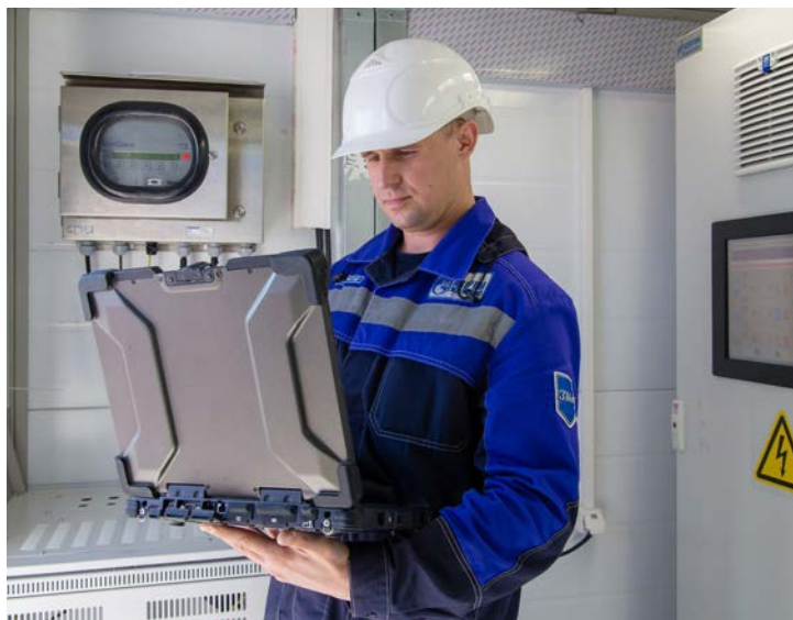
Диагностику контроллера системы телемеханики кустов газоконденсатных скважин ГКП-22 ГПУнРАО проводит инженер по автоматизации и механизации производственных процессов Артем Пигаркин
