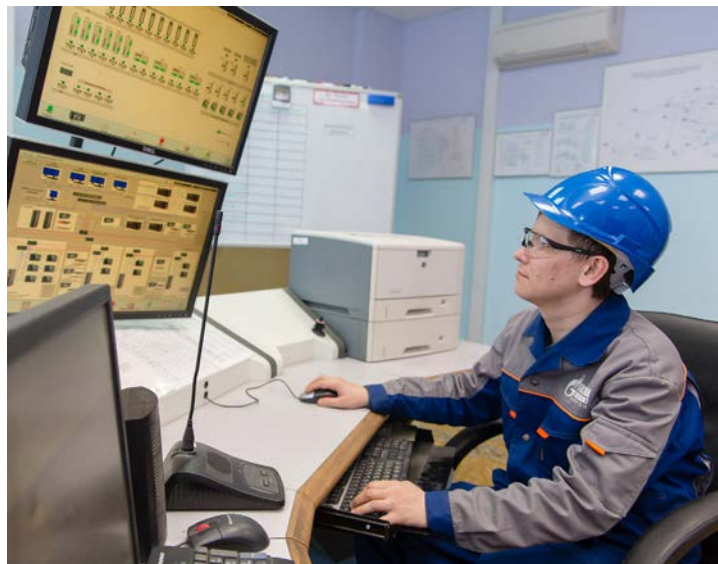
Операторная ГКП-22 – «сердце» промысла. И тут без автоматизации не обойтись. Ведущий инженер-программист Денис Хузин проводит удаленную диагностику терминалов релейной защиты автоматики
